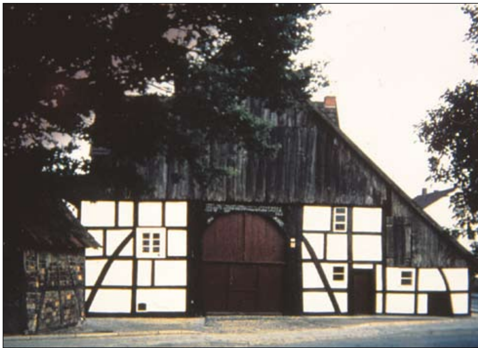
Fachwerkhaus Walter und Therese Kürpick mit Backhaus an der Urbanstraße 29, früher Elsen 89, erbaut 1814, abgerissen 1978. Abbildung: Heimat- und Verkehrsverein, Foto: Josef Weber, 1968
